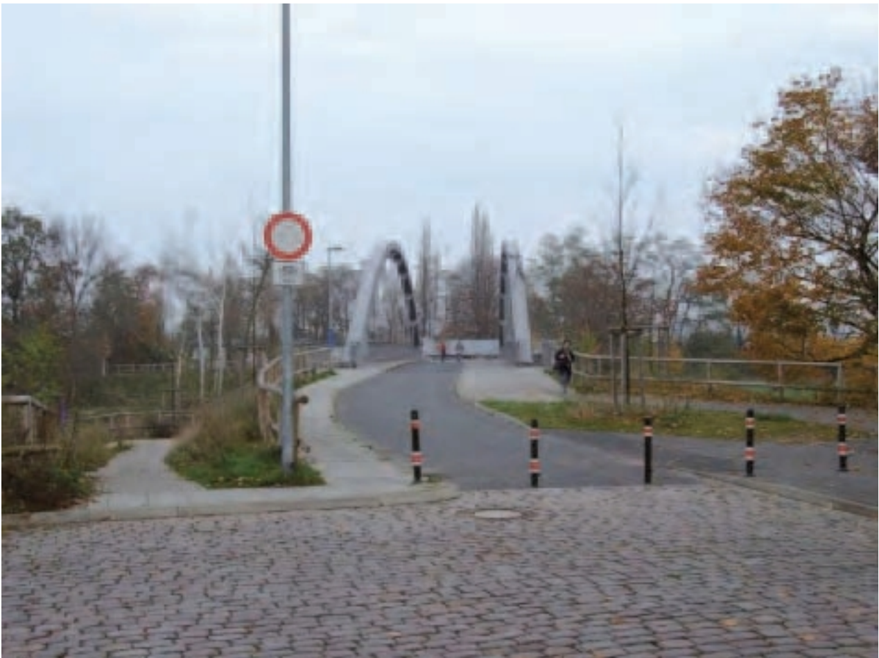
Geh- und Radwegbrücke über den Mittellandkanal
